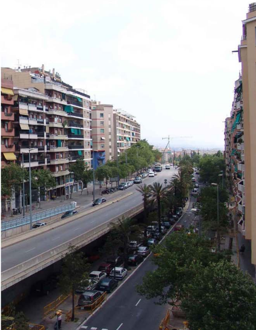
ESTAT ABANS DE L'ENDERROC
